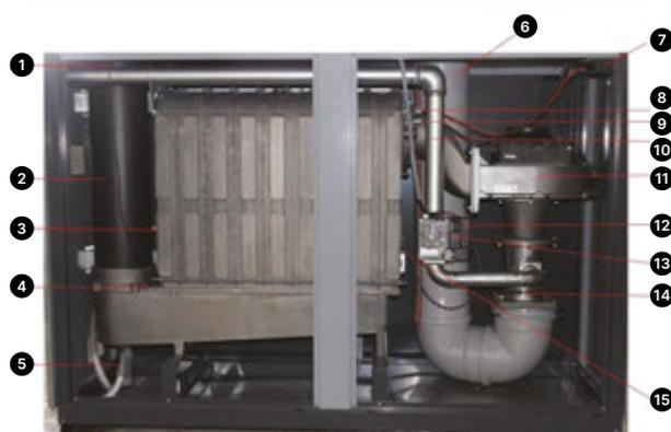
1. Датчик температуры уходящих газов
