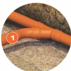
Трубы соединяются через раструб с помощью резинового уплотнительного кольца.
