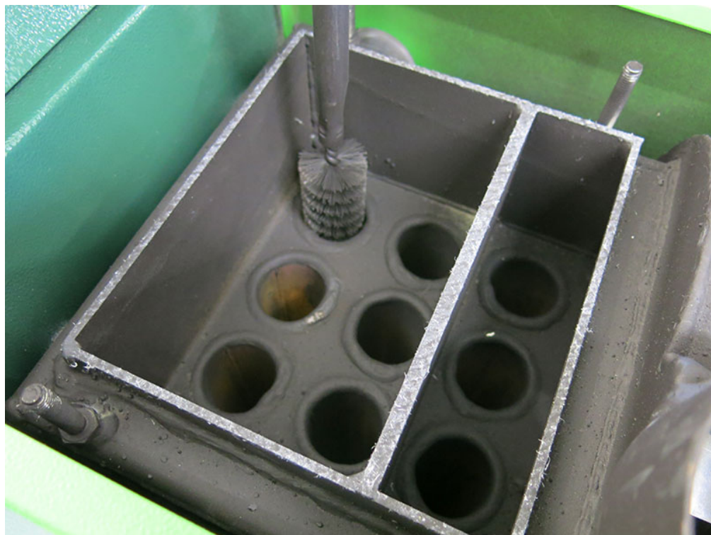
Рис. 36 - Чистка трубчатого теплообменника
